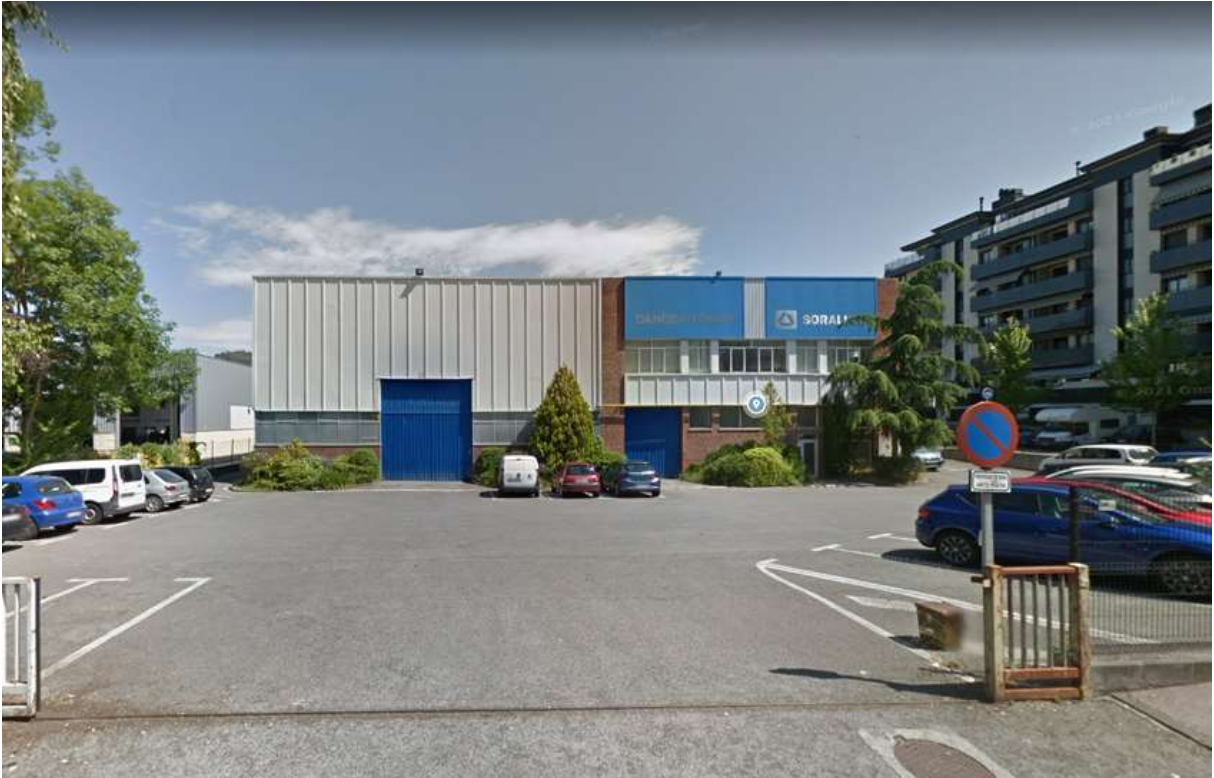
Vistas actual de la fachada principal desde calle Amillaga
